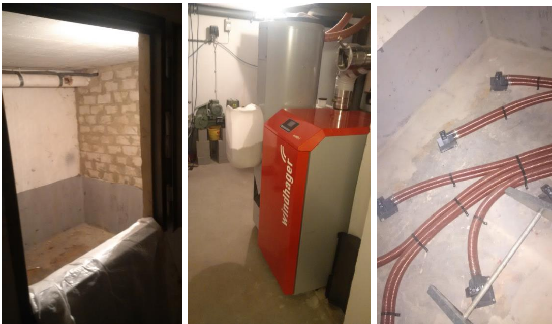
Abbildung 2: Einblick in den Pelletbunker (links), Pelletkessel (mittig) und Saugsonde am Boden des Pelletbunker (rechts).
