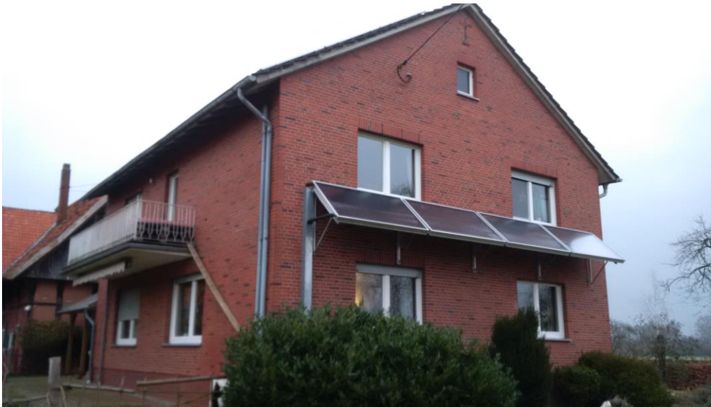
Abbildung 1: Wohngebäude mit Solarthermie-Anlage.
