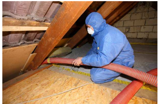
In die Zwischenräume zwischen die Dachsparren wurde Papiercellulose eingeblasen.
