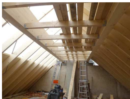
Nachher: Der komplett neue Dachstuhl ermöglicht u.a. eine bessere Dämmung.
