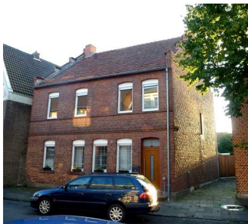
Vorher: So sah das Haus aus dem Jahr 1922 vor der Sanierung aus.
